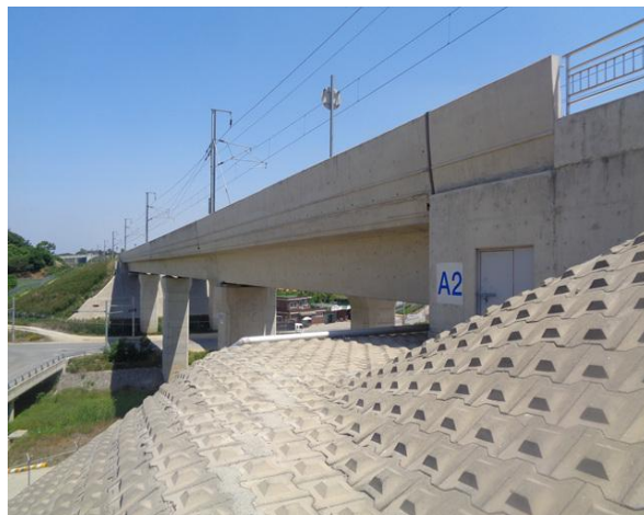
교량 측면 전경
