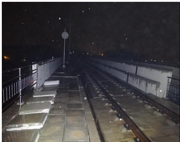
교량 상부 전경
